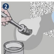
**2** Um eine geeignete Dichtfläche herzustellen, empfehlen wir Kernbohrungen mit ProteX Epoxidharz zu beschichten. Dies dient dazu, den Beton zu schützen und eventuelle Lunker/Riefen zu glätten.
