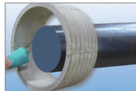
Spachtelmasse gleichmäßig verstreichen, sodass die Innenwand eine homogene Dichtfläche bildet, ggf. überschleifen
